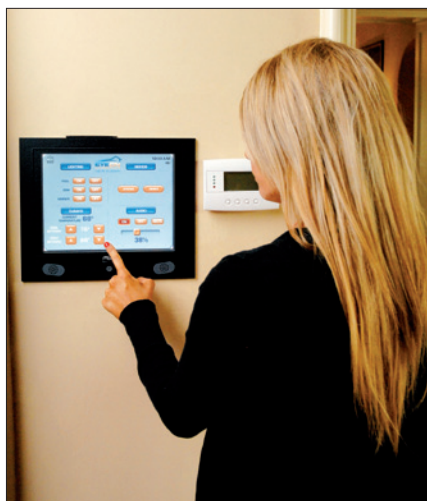
Obr 1. Systém od firmy EyeOn Automation přetvoří každý dům na technicky vyspělou budovu: ovládací panely řady Power Panel rozmístěné po domě umožňují nastavovat a programovat rozličné parametry, např. osvětlení, tepelné pohody atd.
