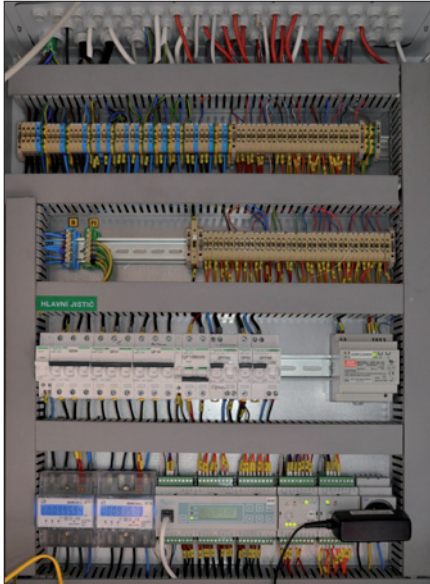
Obr. 1. Rozváděč s jističi a regulátorem IR-30
