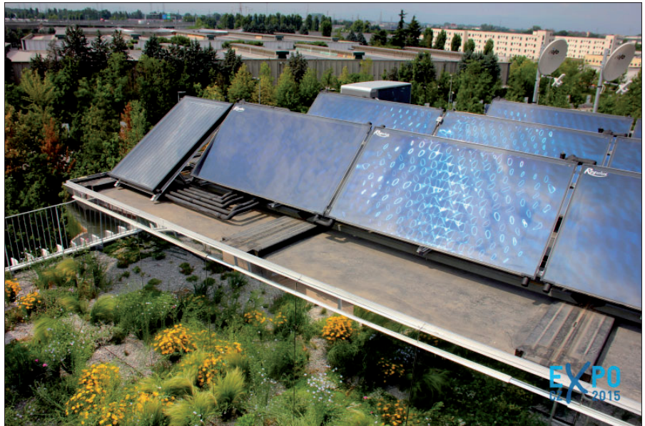
Obr. 2. Firma Regulus instalovala na střeše pavilonu ve slunné Itálii řadu termických solárních panelů
