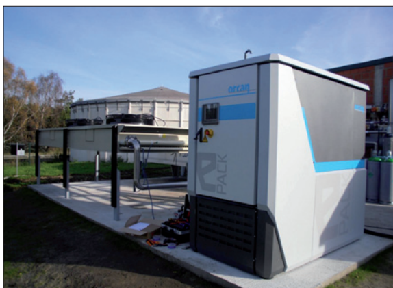
Obr. 1. Systém ePack využívající ORC v bioplynové stanici Potsdam-Mittelmark v Německu
