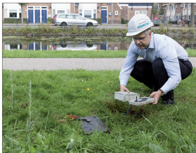
Obr. 1. Pracovník společnosti Siemens kontroluje snímač uložený v tělese hráže (foto: Siemens AG)
