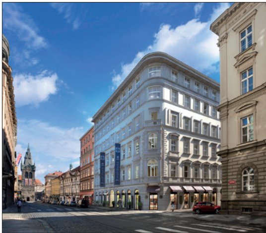
Obr. 1. Pohled na zrekonstruovanou budovu Jindřišská 16
