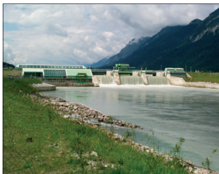
Obr. 1. Pro elektrárnu Langkampfen společnosti TIWAG na řece Inn dodala firma Andritz dvě přímotoké turbíny o průměru 5,15 m a výkonu 17 510 kW
