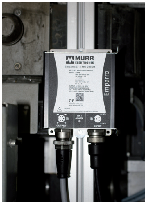
Obr. 1. Spínaný síťový napájecí zdroj Emparro67 lze instalovat i mimo rozváděč přímo do provozního prostředí
