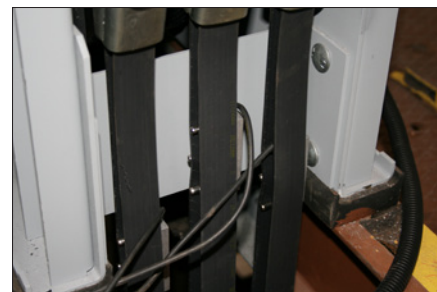
Obr. 3. Detail nosných pryžových pásků a tenzometrických snímačů zatížení kabiny
