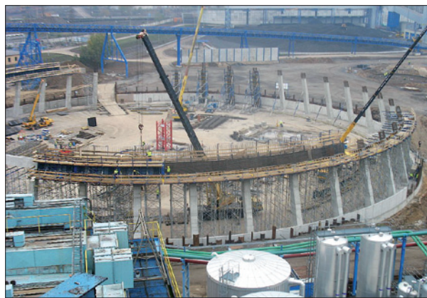
Obr. 1. V současné době se v Ledvicích staví nová chladič věž pro potřeby budovaného bloku 4
