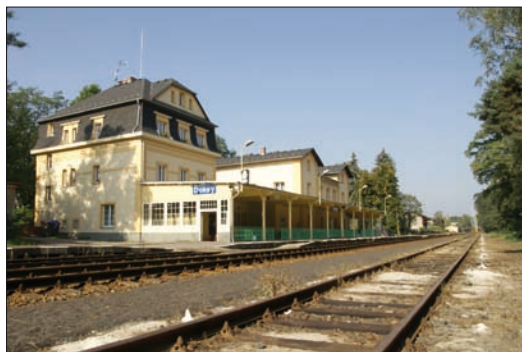
Obr. 1. Železniční stanice Doksy na modernizované trati Bakov nad Jizerou – Česká Lípa
