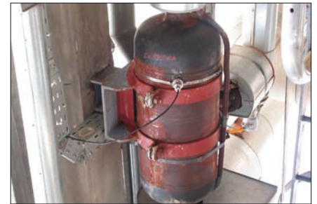
Obr. 4. Ultrazvukový snímač E03 instalovaný na separátoru pro oddělení dvou frakcí produktu
