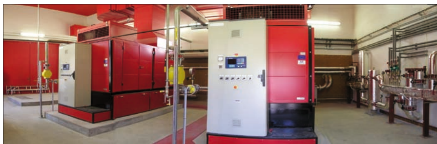
Obr. 2. Kogenerační jednotky
