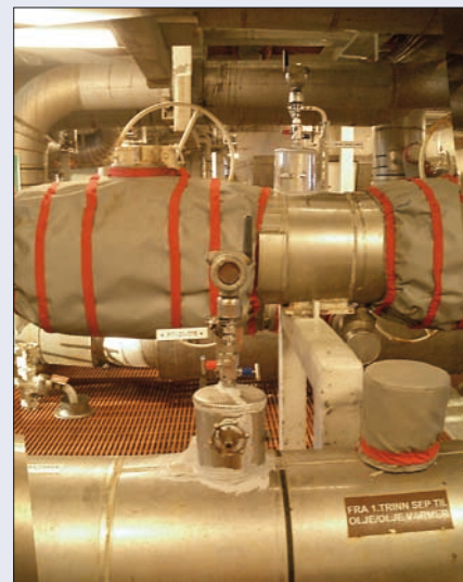
Jeden z bezdrátových převodníků tlaku Rosemount na plošině Grane
