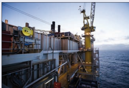
Plovoucí těžní plošina Grane společnosti StatoilHydro
