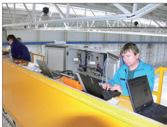
Obr. 2. Odstraňování poruchy v provozu zákazníka
