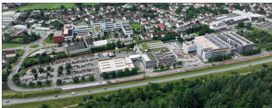
Obr. 1. Areál společnosti Endress+Hauser v Maulburgu, stav v červenci 2024
