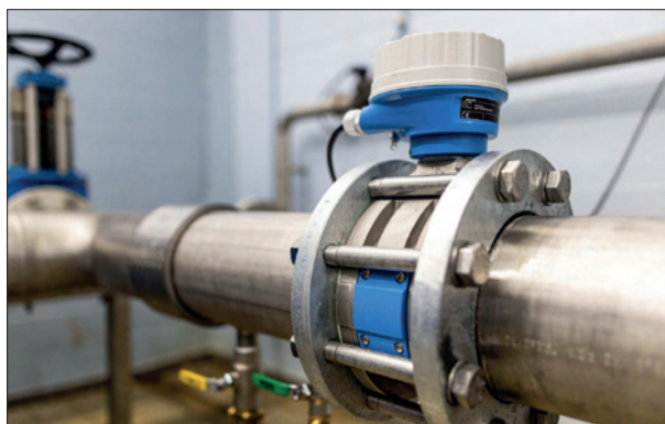
Obr. 3. Přístroj Proline Teqwave MW instalovaný přímo v potrubí měří celkový obsah pevných látek v kalech čistíren odpadních vod
