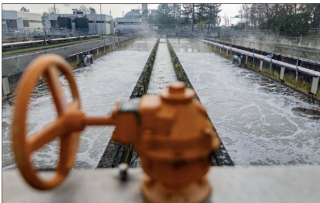
Obr. 1. Sledování obsahu pevných látek je v čistírnách odpadních vod klíčové pro bezpečný a efektivní provoz
