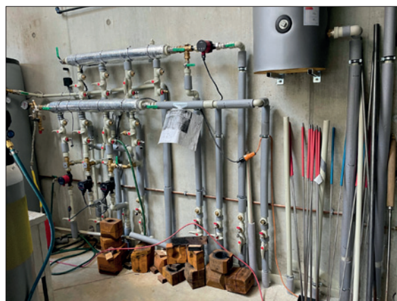
Obr. 4. Rozvody, cirkulace a ovládání teplé vody
