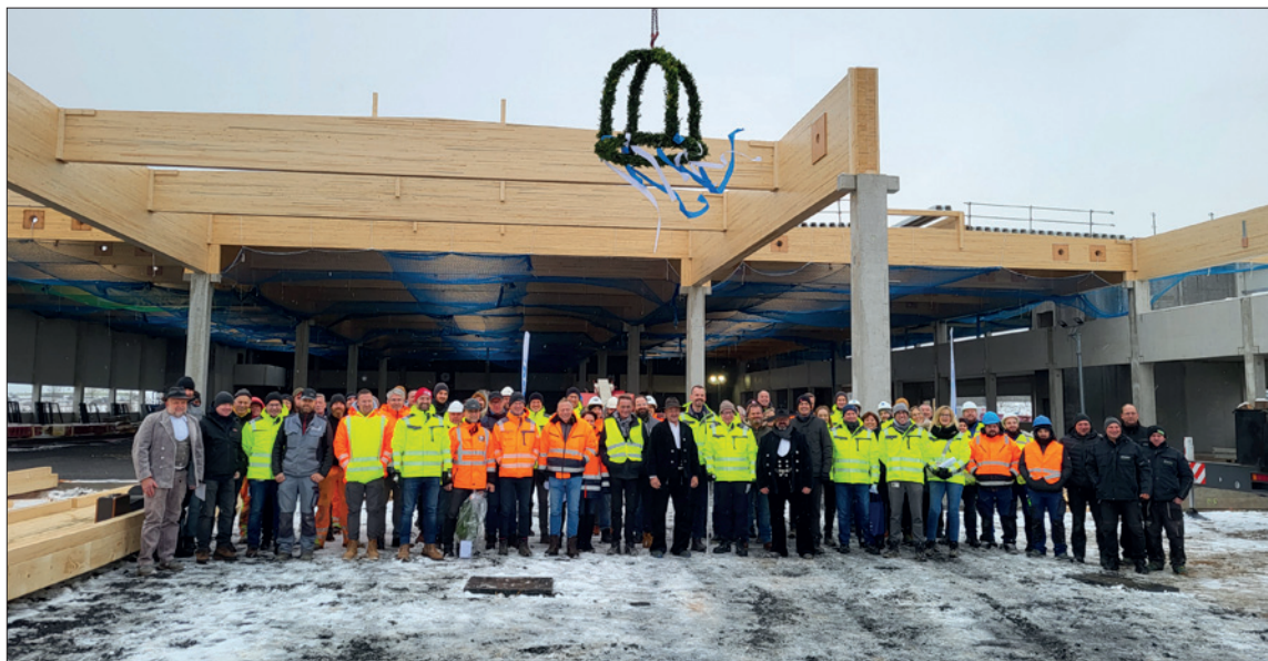
Obr. 1. Stavební práce na výrobním závodě JUMO SENSILO v technologickém parku Fulda-West rychle pokračují
