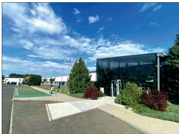
Obr. 5. Výrobní závod Schneider Electric v Písku získal ocenění Net Zero Carbon Site, a zařadil se tak mezi zhruba 30 prvních uhlíkově neutrálních podniků Schneider Electric
