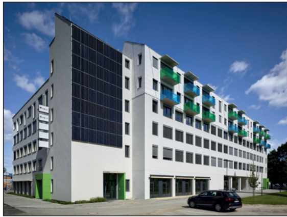
Obr. 3. První ze tří budov brněnského brownfieldu Svatopečská v Brně se proměnila na moderní sídlo se šestnácti nízkoenergetickými bytovými jednotkami určenými k nájemnímu bydlení a s komerčními plochami; přes 500 snímačů a měřidel spotřeby poskytuje data systému EcoStruxure od Schneider Electric, díky kterému je areál maximálně úsporný
