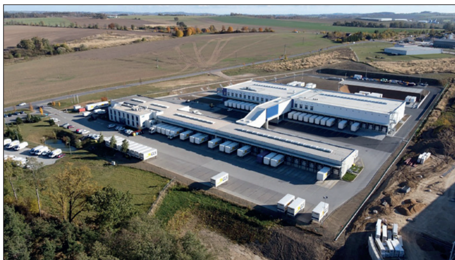
Obr. 2. Logistické a distribuční centrum GLS v Jihlavě využívá EcoStruxure Building, řešení od Schneider Electric, k měření, řízení a vyhodnocování energetických toků celé budovy
