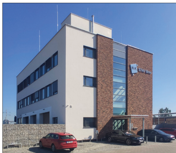
Obr. 1. Dvoupatrová budova nového administrativního sídla firmy N.K. STAV
