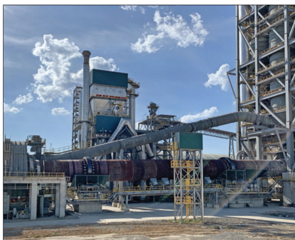
Obr. 2. Klíčová součást cementárny – rotační cementářská pec
