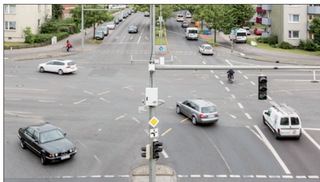
Obr. 2. Křižovatka se zařízením pro automatizované odbočování doleva (foto: DLR)
