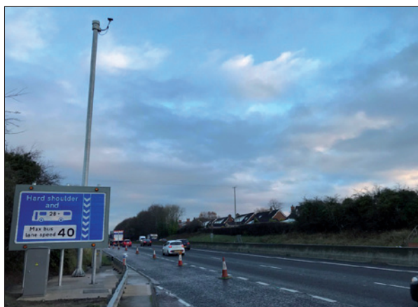
Obr. 1. Nejvytíženější dálnice v Belfastu mají vyhrazený postranní pruh pro autobusy monitorovaný kamerovým systémem a začleněný do systému řízení přednosti pro hromadnou dopravu
