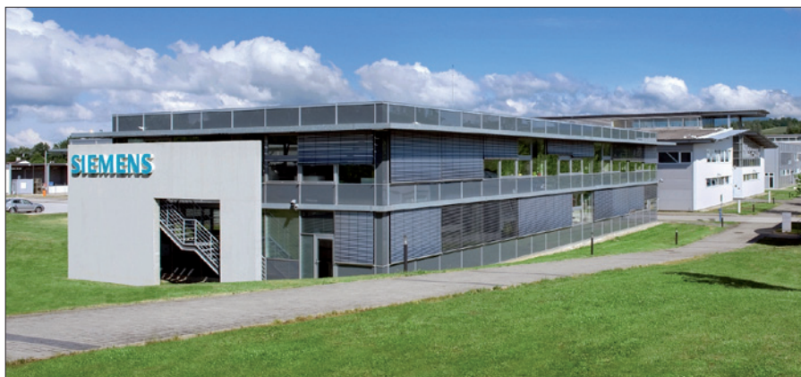
Obr. 1. Nová hala firmy Siemens Nízkonapěťová spínací technika má plochu 7 422 m 2
