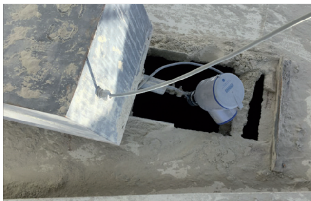
Obr. 1. Radarový hladinoměr s frekvencí 80 GHz OPTIWAVE 6500 s čočkovou anténou instalovaný na silu
