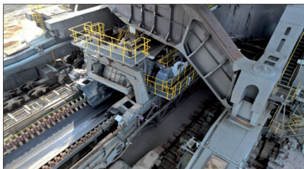
Obr. 1. Bezpřevodový pohon ABB s motorem s permanentními magnety byl v červenci 2017 uveden do provozu v povrchovém dole Jämschwalde v Německu
