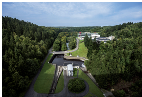
Obr. 2. Zařízení kritické infrastruktury využívají zabezpečený protokol DNP3
