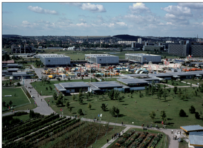
Obr. 1. Výstaviště Agrokomplex v Nitře bylo původně vybudováno především pro zemědělské výstavy (historické foto z roku 1983)
