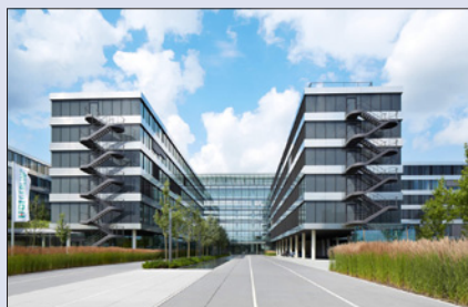
Budova firmy HDI Gerling v Hannoveru vybavená pokročilým řízením ochrany proti slunci
