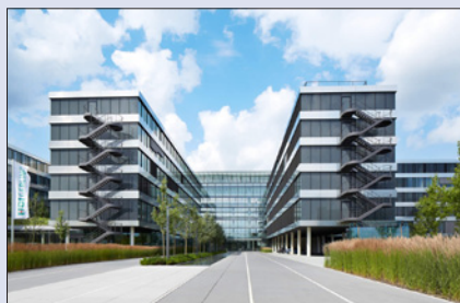
Budova firmy HDI Gerling v Hannoveru vybavená pokročilým řízením ochrany proti slunci
