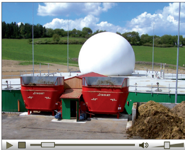
Obr. 1. Pohled na bioplynovou stanici; reportáž ke zhlédnutí na http://bit.ly/bioplynka_mrakov
