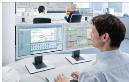
Obr. 1. Operátorská stanice systému Simatic PCS7 je oknem do reálné výroby: zde lze sledovat a řídit všechny fáze technologických procesů
