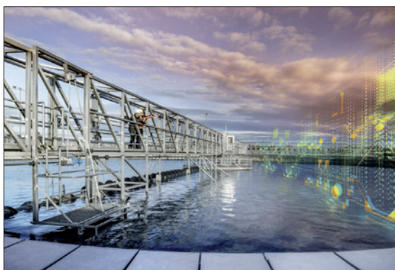
Obr. 1. Digitalizace ve vodárenství a čistírenství – pod tímto mottem společnost Siemens představila na výstavě Vodovody-Kanalizace v Praze-Letňanech ukázku nejmodernějších systémů a digitálních řešení
