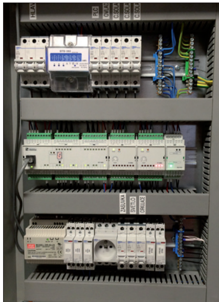
Obr. 3. Pohled do skříně řídicího systému Energy Face s programovatelným automatem Tecomat Foxtrot
